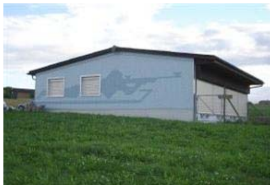
Die Schiessanlage der Sportschützen Buchackern ist zeitgemäss eingerichtet.
